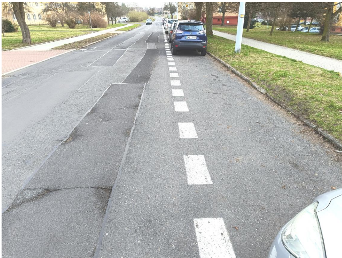
Obr. č. 9 – Jižní parkovací pruh v úseku mezi Horskou a Boreckou v zachovalém stavu, avšak s rozpadlými obrubníky, nesčetné lokální opravy jízdního pásu:
