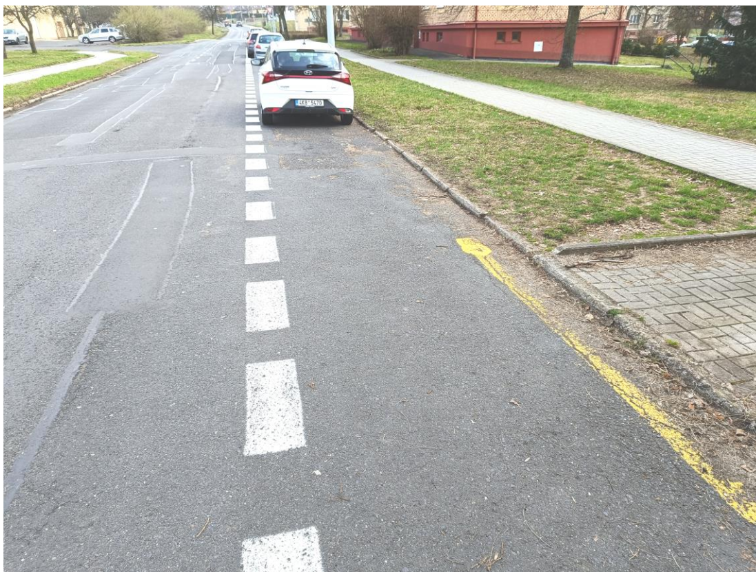
Obr. č. 10 – Mírné poškození obrubné vrstvy jižního parkovacího pruhu, avšak staré obrubníky, na severní straně rozpadlé obrubníky způsobily snížení únosnosti podkladních vrstev a vznik síťových trhlin, vozovka s reflexními trhlinami mnohonásobně opravovaná:
