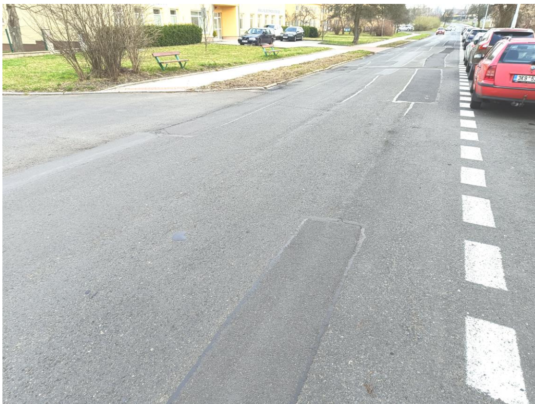
Obr. č. 8 – Sít'ové trhliny vlevo způsobené snížením únosnosti podloží v důsledku malého podélného spádu a následným dlouhodobým zvodněním okraje vozovky díky jejímu poklesu a nefunkčním obrubníkům:
