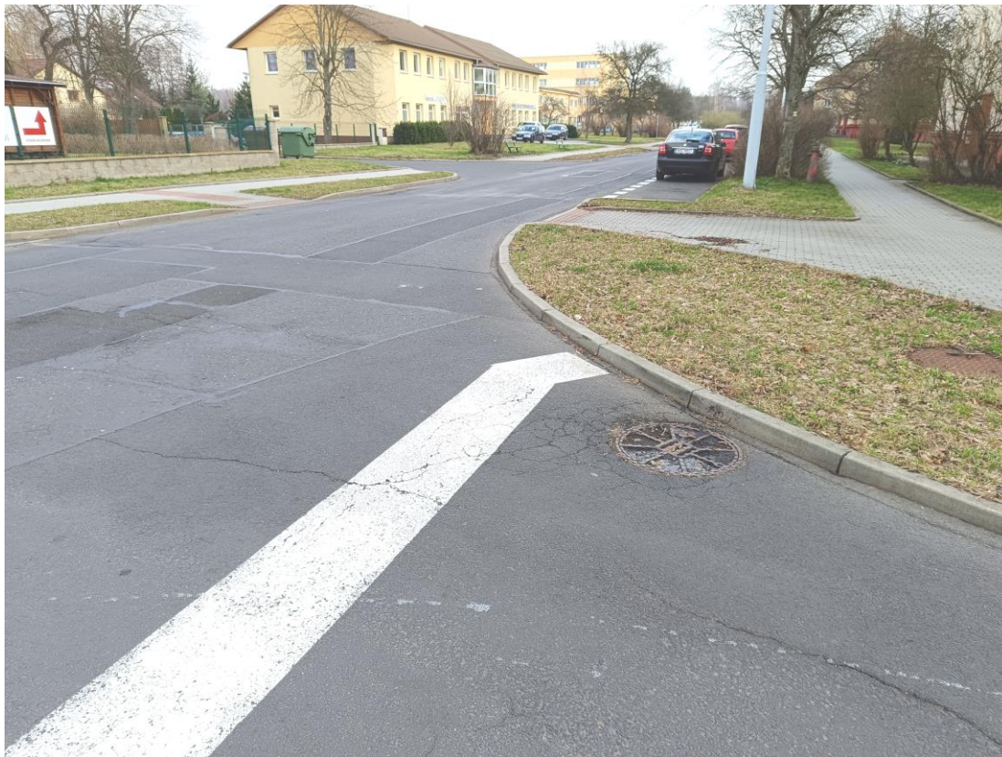
Obr. č. 7 – Sít'ové a reflexní trhliny v oblasti křižovatky s ulicí Horskou:
