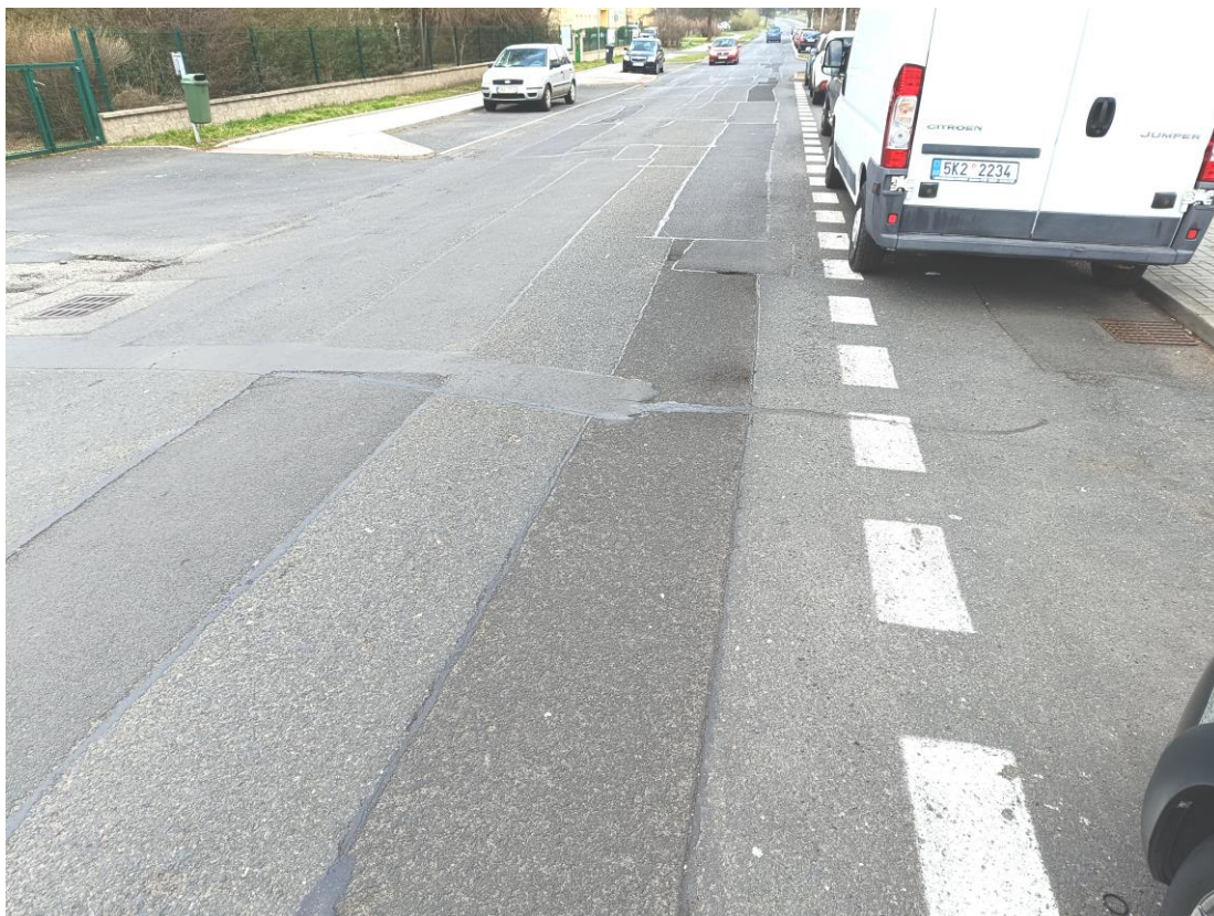
Obr. č. 5 – Několikanásobné lokální opravy v minulosti, jižní parkovací záliv s mírným poškozením:
