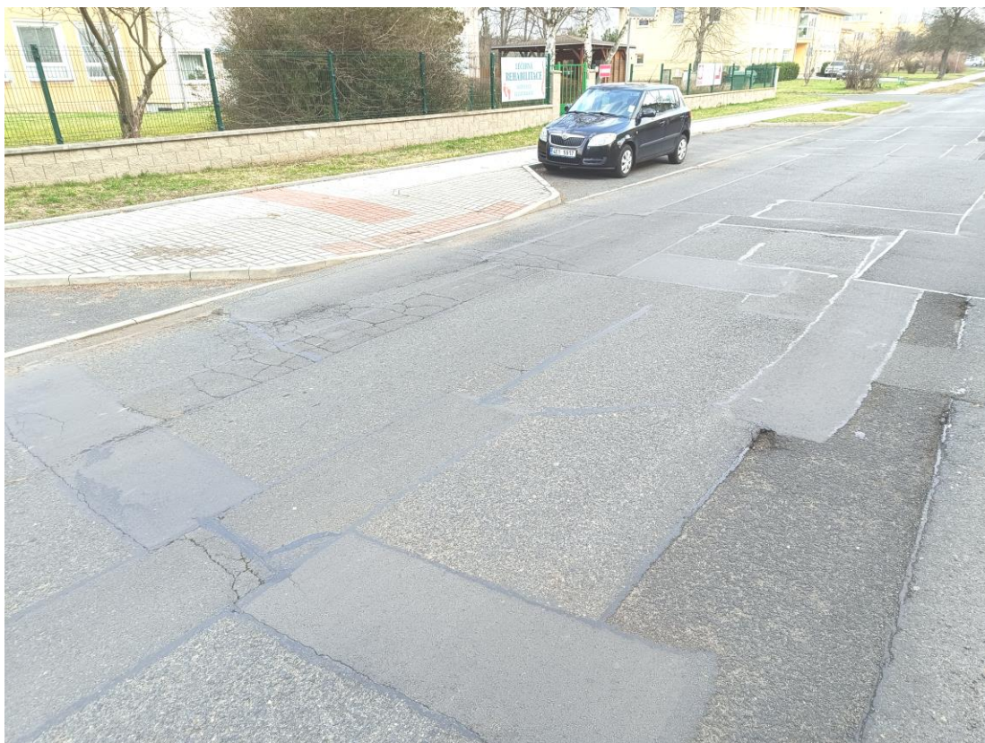
Obr. č. 6 – Síťové trhliny ve stopě vozidel způsobené neúnosným podložím, severní parkovací záliv včetně obrubníků v dobrém stavu:
